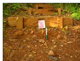
Degraus com base erodida
